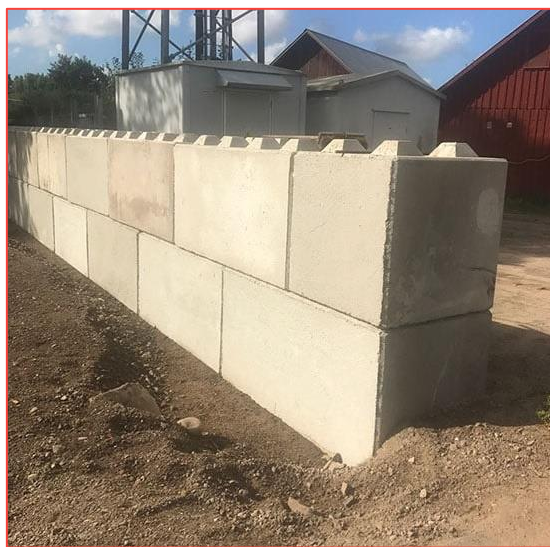
Figur 3.5.1. Bild på den typ av block som gjuts av restbetong och kan byggas ihop till temporära eller permanenta skiljeväggar mm.
