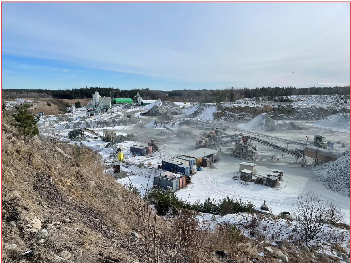
Figur 3.2.2. Översiktssbild från Olundatäkten med del av kross- och sorteringsanläggningen för bergtäkten. I bakgrunden till vänster i bilden syns även betongstationen med tillhörande silos.
